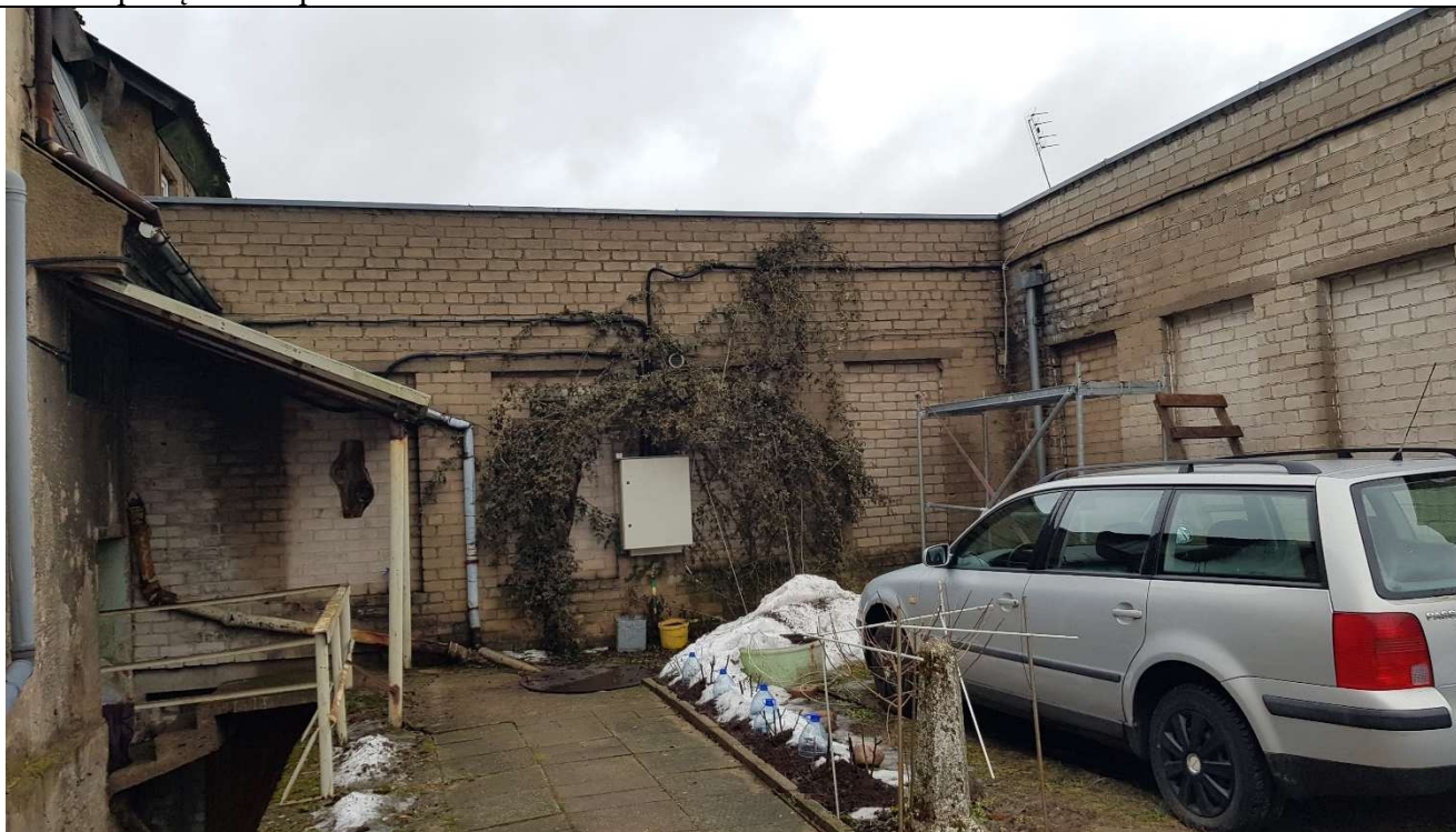
Pastato vakarų fasado pusė.
