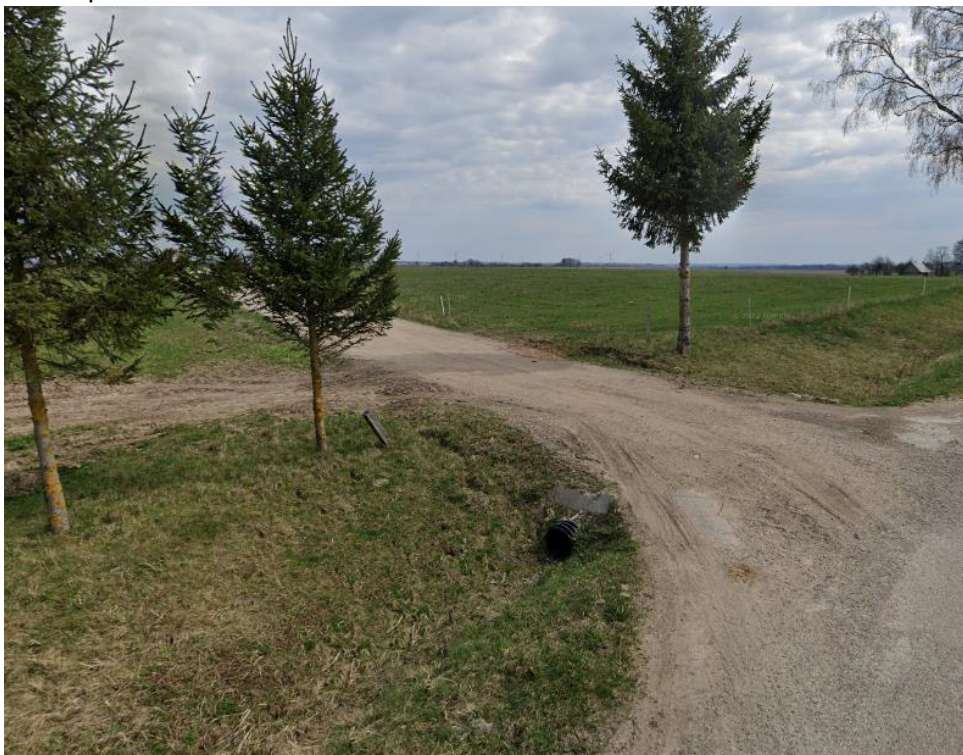
Pav. 2. Kelio nuovaža PK 95+40
